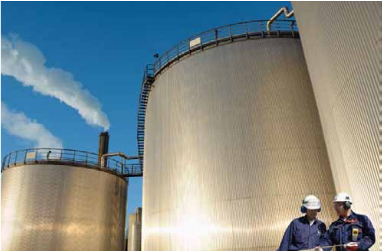
Isolation de cuves de pétrole par bac acier avec ondes trapézoïdales en Grande-Bretagne
