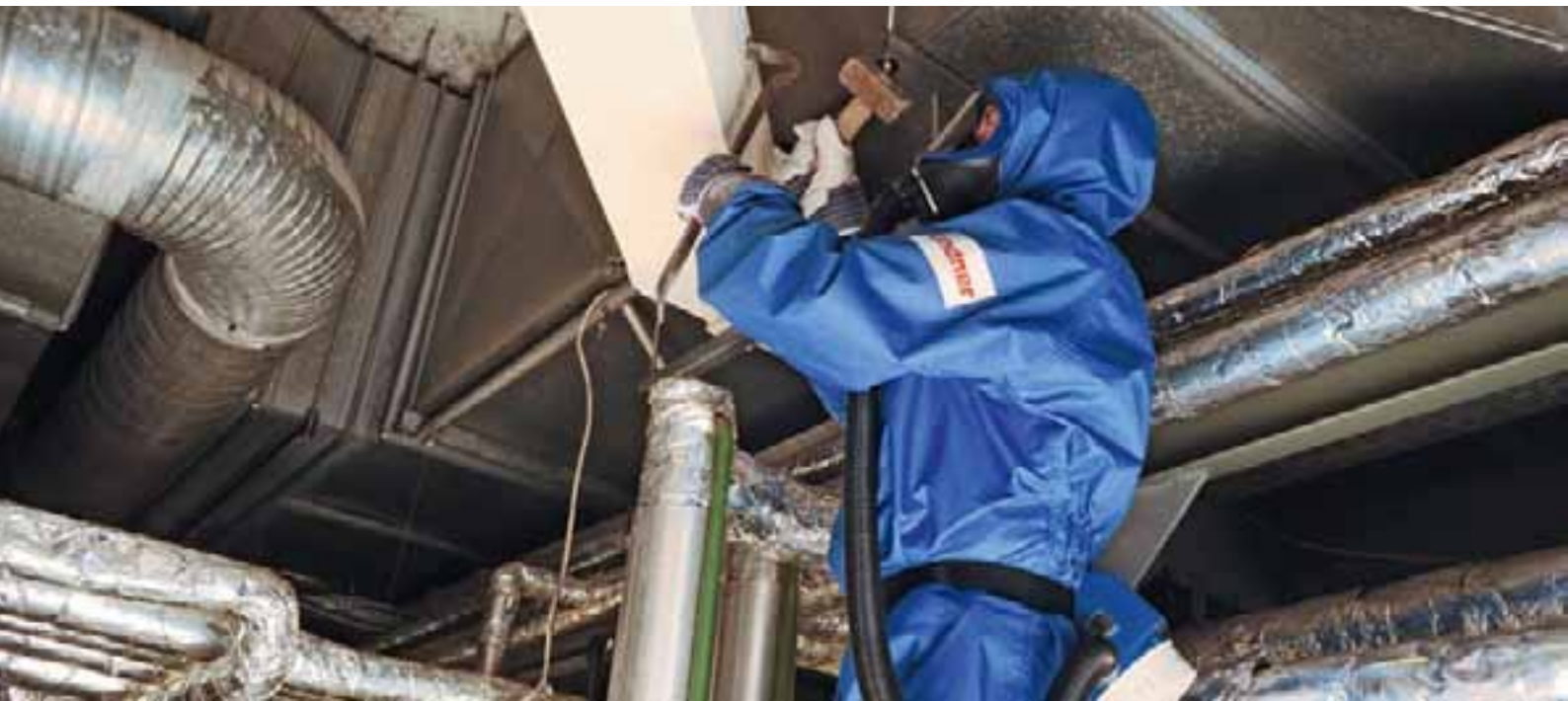
Dépose d'une gaine de ventilation contenant de l'amiante
