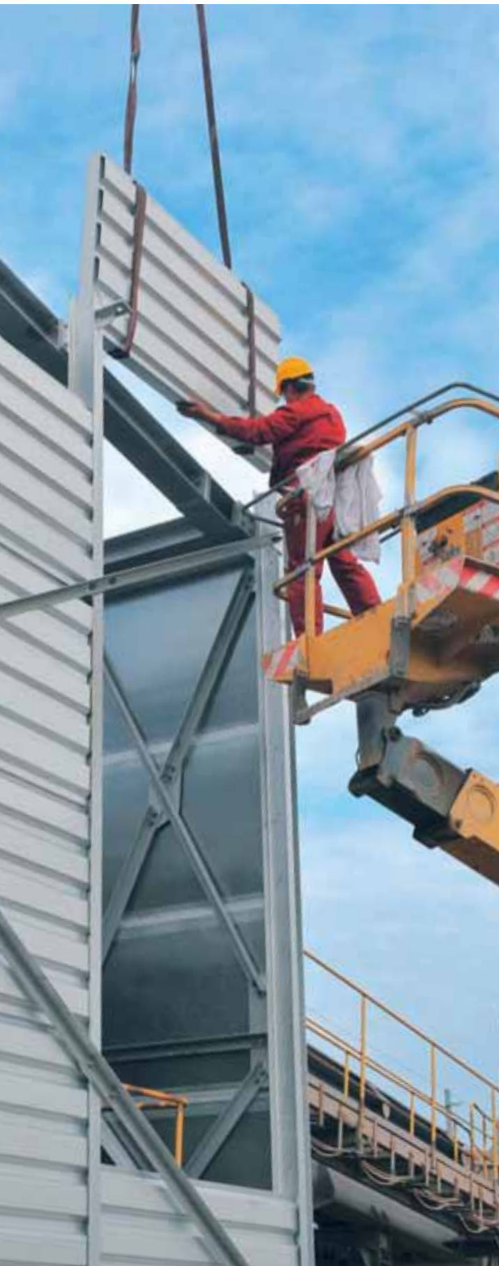
Schallhaube auf einer Antriebsstation im Braunkohletagebau Schleenhain
