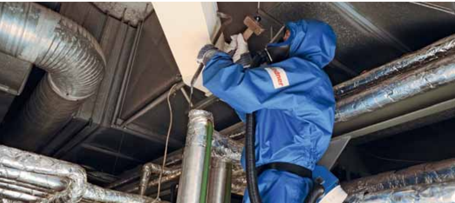
Entfernung eines asbesthaltigen Lüftungskanals
