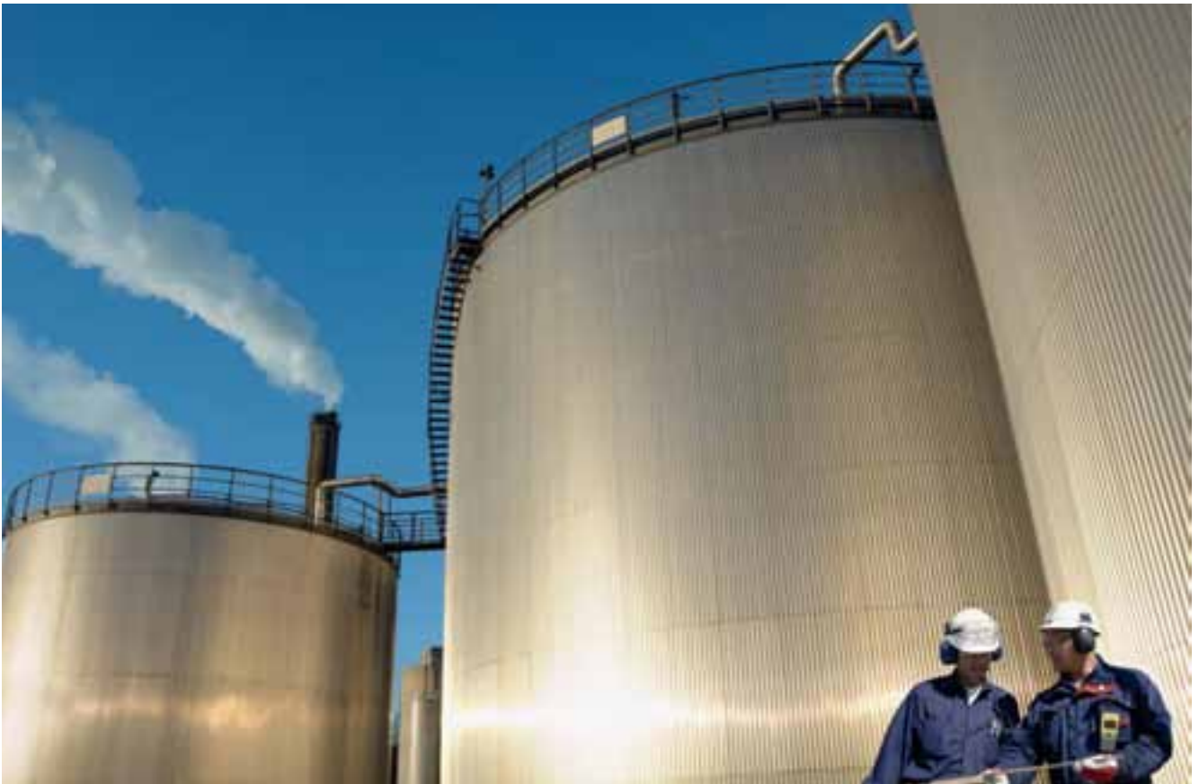
Öltankisolierung mit Trapezblech in Großbritannien
