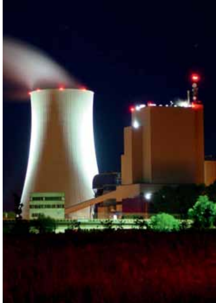
Außenansicht der Müllverbrennungsanlage Intradel, Herstal, Belgien
