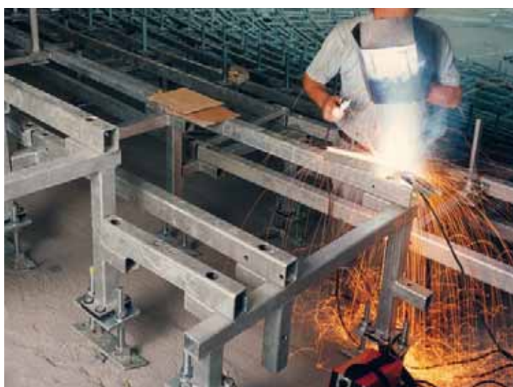
Специально разработанная конструкция трибуны для аудитории технического университета Гархинг
