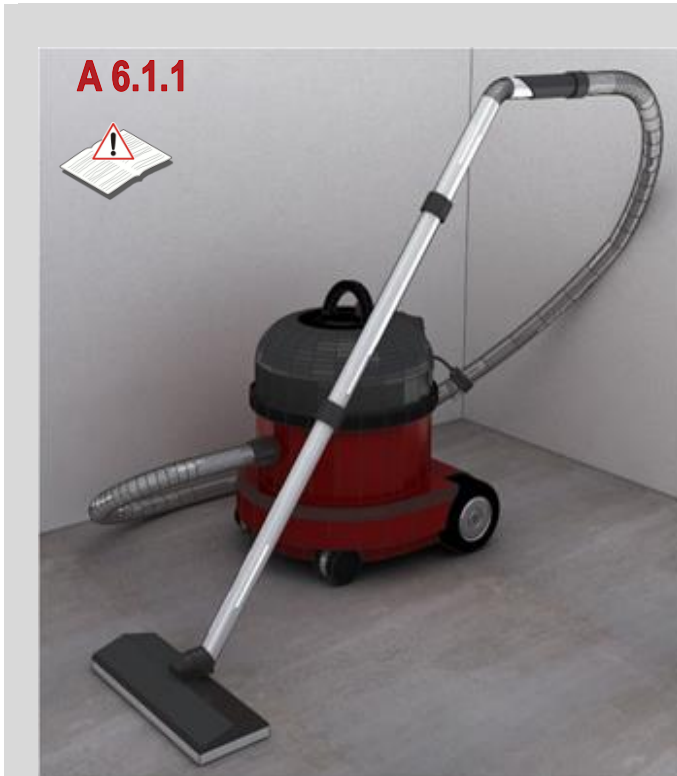
Abbildung 4 Reinigen des Rohbodens
