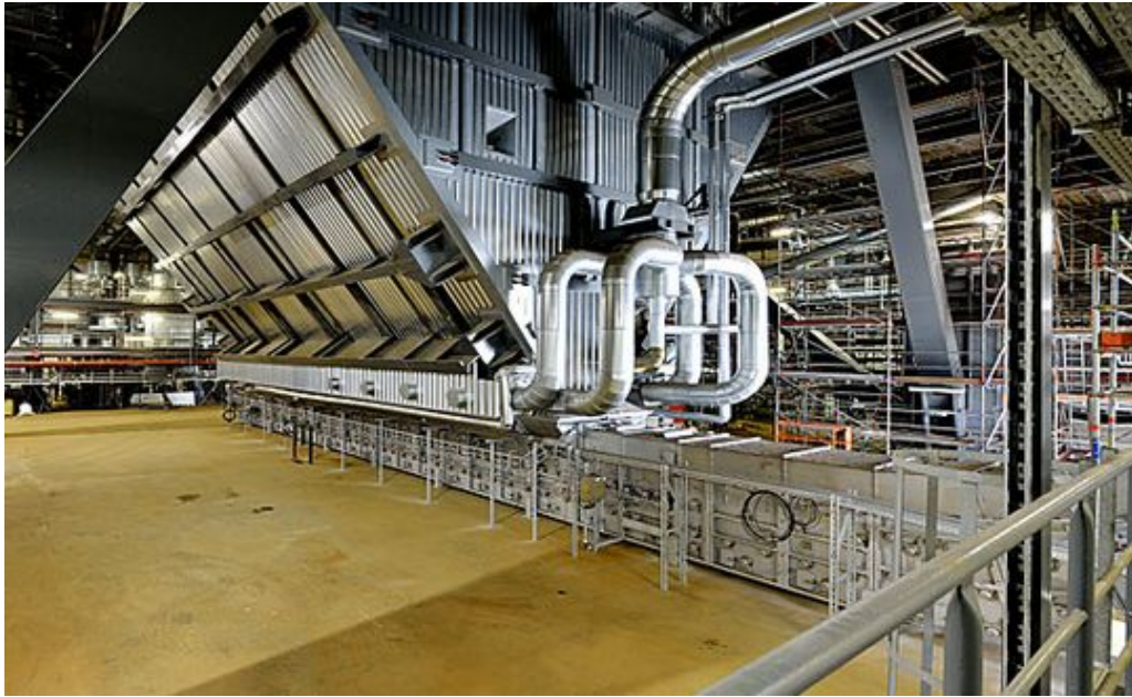
Ausführung der Gewerke: Kraftwerksisolierung
