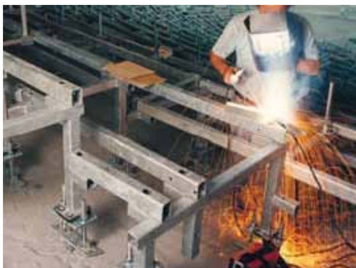
Construction de tribune développée spécialement pour la salle de conférence de l'université technique de Garching
