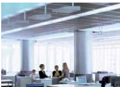
Plafond en métal déployé
