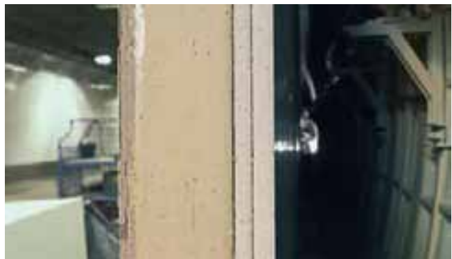
Spaltwand mit Brandschutzbekleidung.
