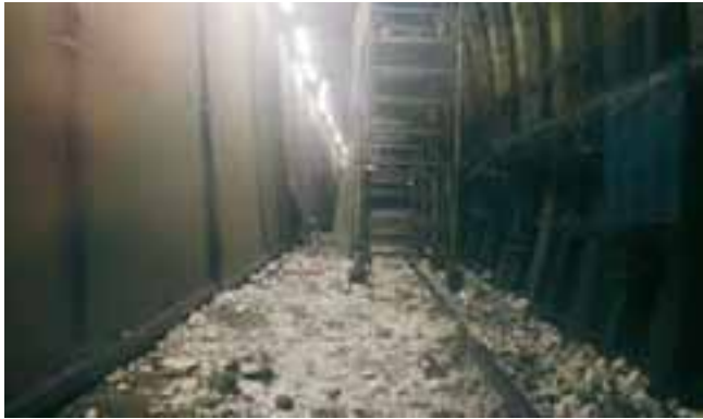
„Schwarzbereich“ - abgeschotteter Arbeitsbereich im Altzustand mit Spritzasbest vor dem Sandstrahlen.
